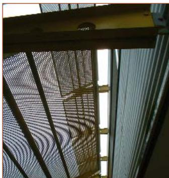
Les brise-soleil horizontaux peuvent prendre de nombreuses formes. Ce sont des éléments horizontaux qui peuvent être en bois, en aluminium, en acier ou en béton, posés au dessus des ouvrants.
