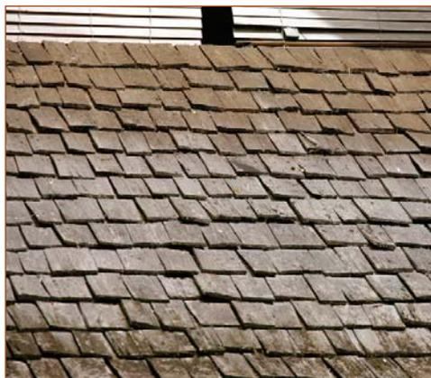
Éléments de bois de faible épaisseur posés à recouvrement.
