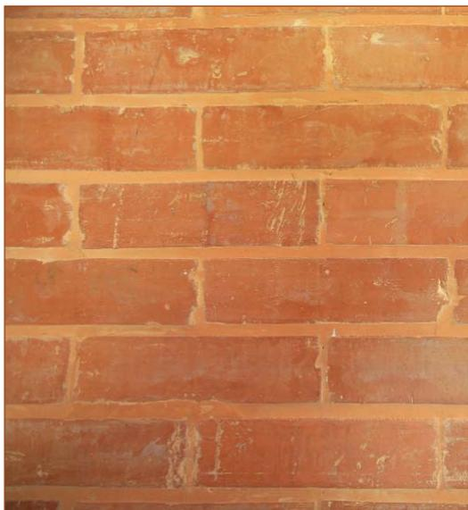
Les briques de terre cuite sont des blocs pleins de petite taille constitués de terre argileuse cuite. Ils sont mis en œuvre avec un mortier de ciment.
