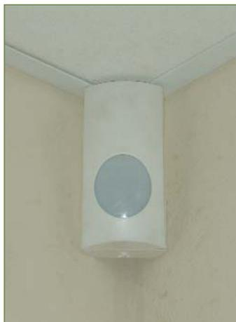
En permettant d'asservir le fonctionnement d'appareils électriques à la présence ou au passage d'une personne, ce type d'équipement permet de réaliser des économies significatives.
