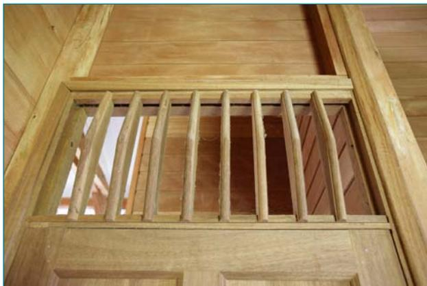
Ouvertures dans un mur permettant la libre circulation du vent dans le bâtiment, les impostes sont des pièces de menuiserie (en alu, acier, fer forgé ou bois) ou de maçonnerie.
