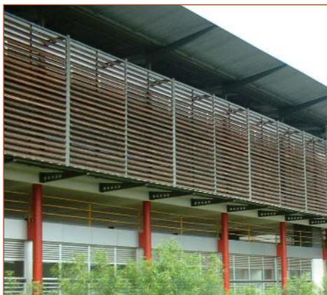
Les brise-soleil verticaux peuvent prendre de nombreuses formes. Ce sont des lames, en bois ou en aluminium, posées parallèlement à la façade.
