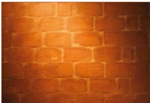
Les briques de terre crue sont des blocs pleins constitués de latérite et de chaux, qui sont comprimés puis séchés à l'air libre. Elles sont ensuite mises en œuvre avec un mortier de ciment ou de chaux.
