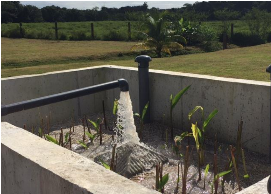
Écoulement d'une bâchée toutes les 2 heures pour permettre ...
