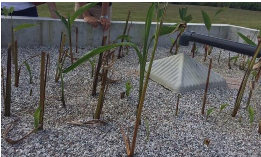
Bac de 6m 2 de filtres planté de végétaux
